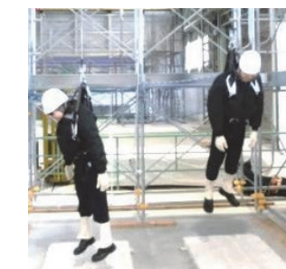
フルハーネス型墜落制止用器具 につられる危険体感教育
